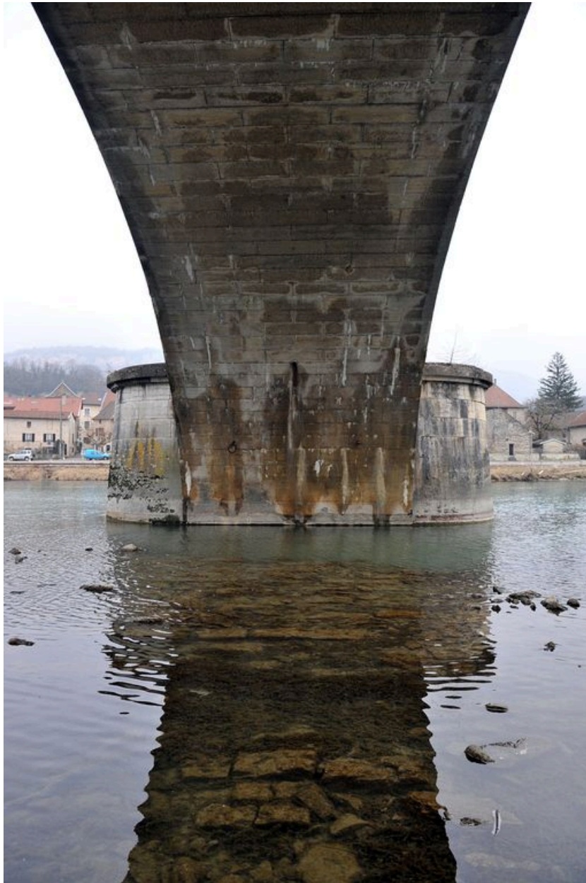
Vue de dessous, arche et pile (depuis la rive gauche)
