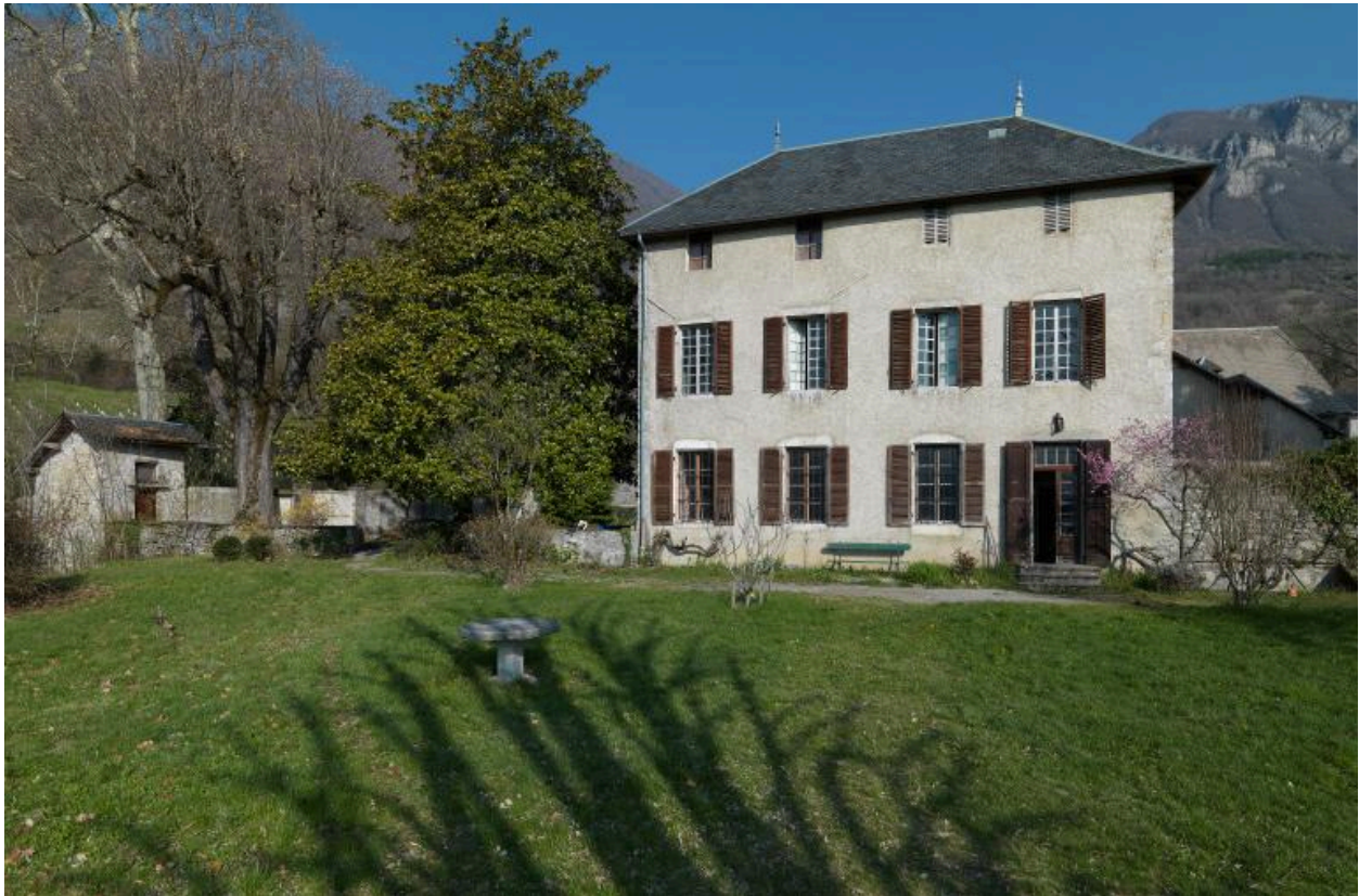
Vue d'ensemble de la façade sud de la demeure donnant sur le jardin.
