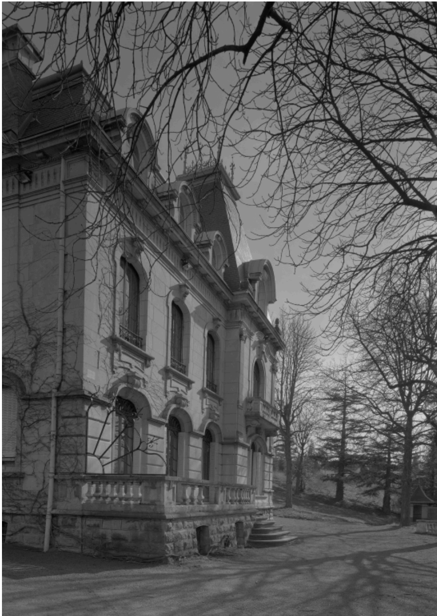
Vue de la façade ouest de la maison, du nord-ouest.
