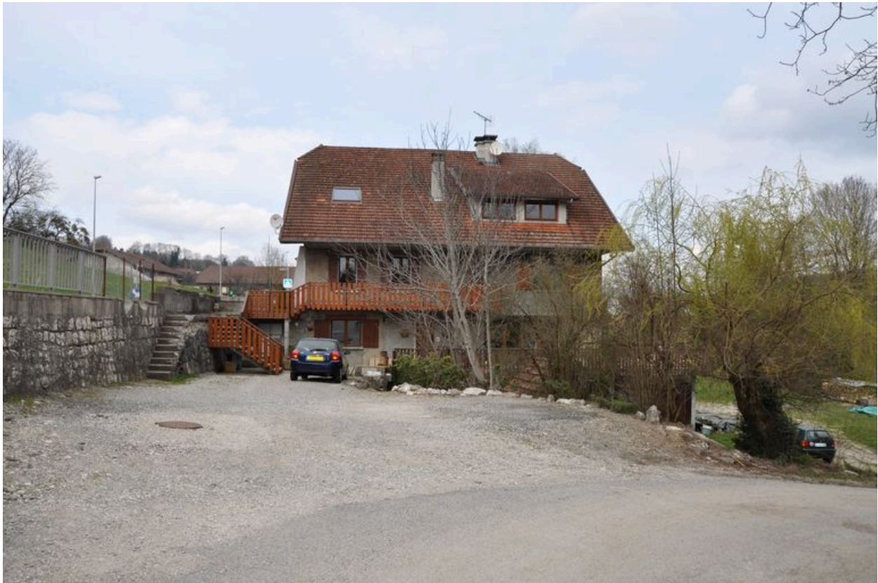
Vue de la façade latérale sud prise depuis le chemin du moulin
