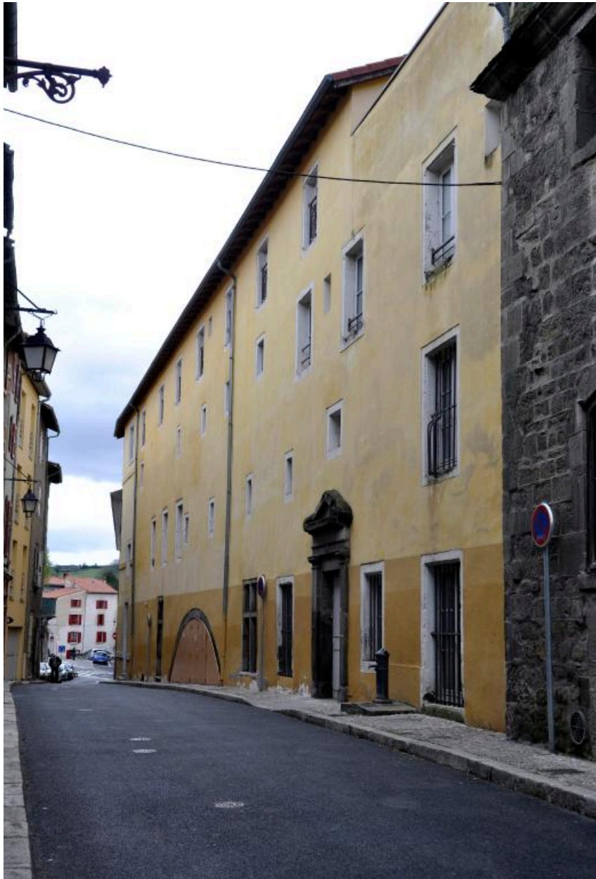
Bâtiment E, élévation sur rue depuis l'ouest
