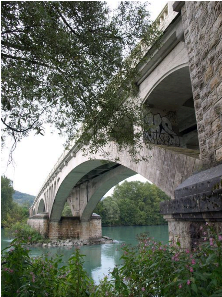
Arches, face aval (depuis la rive gauche)
