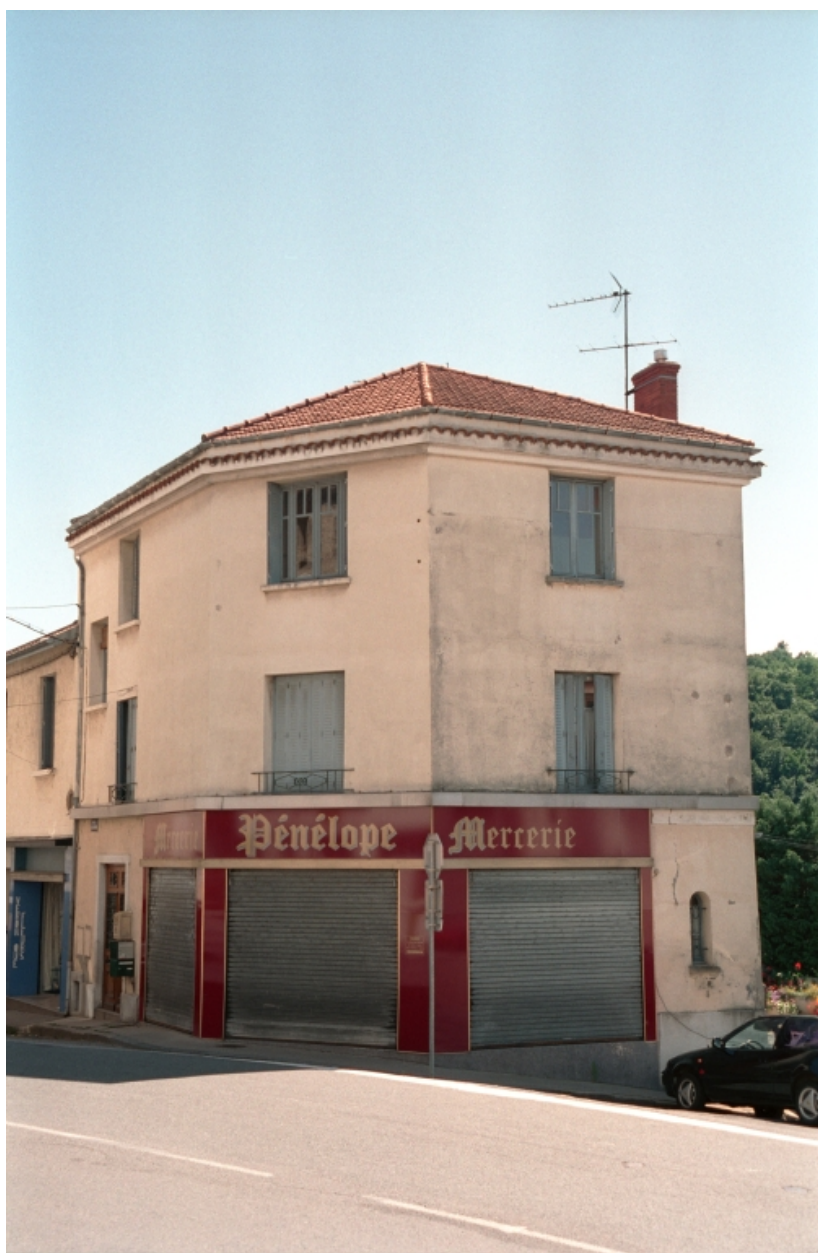
Boën, îlot 14, Clermont (rue de) 46. Vue générale des façades sur rue.
