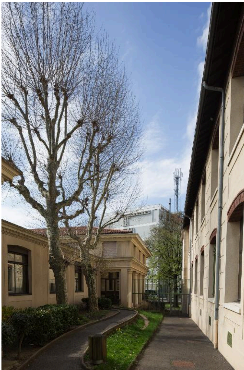
Bâtiment A et accès au bâtiment E
