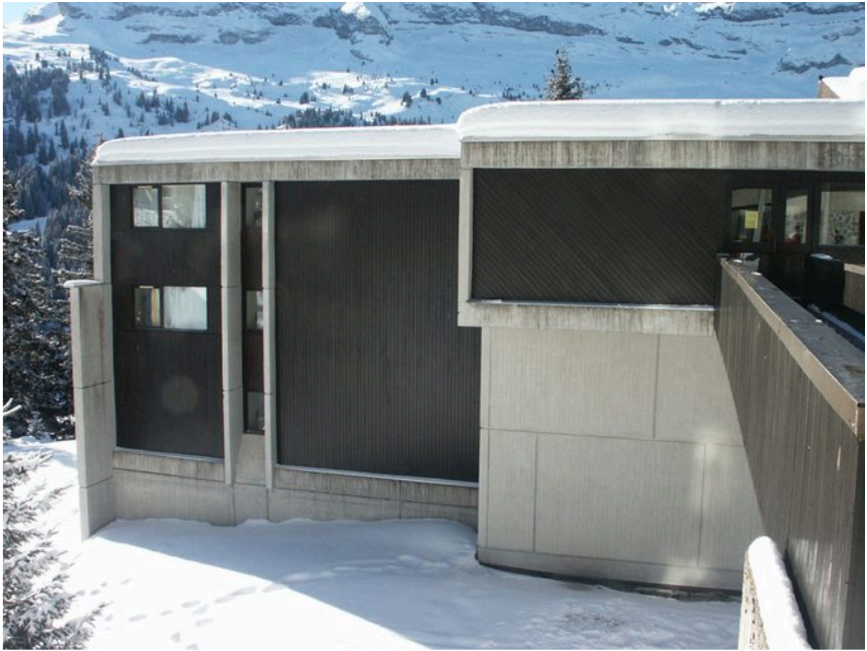
Elévation principale, partie est
