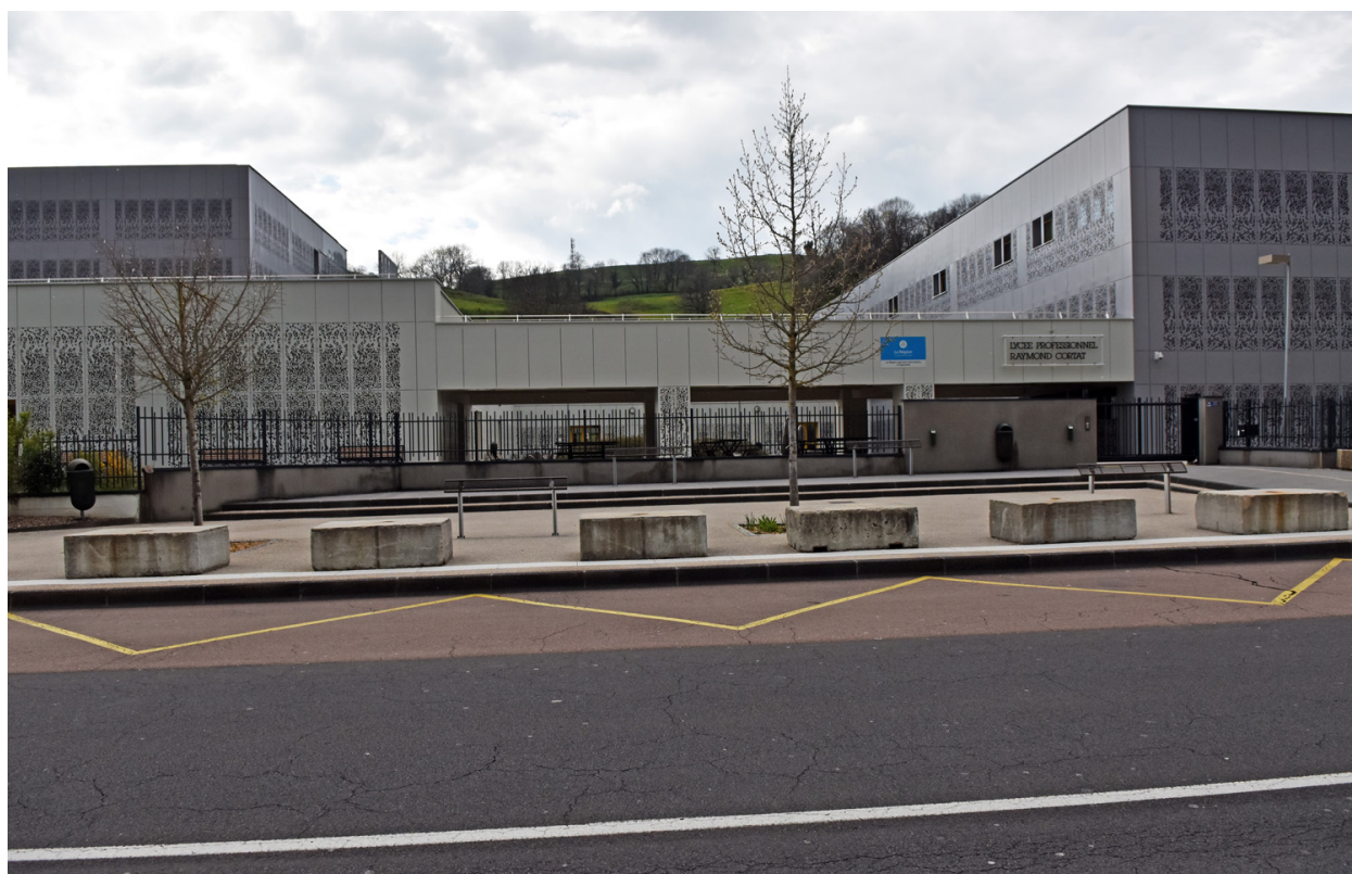
Vue d'ensemble depuis le sud, après travaux
