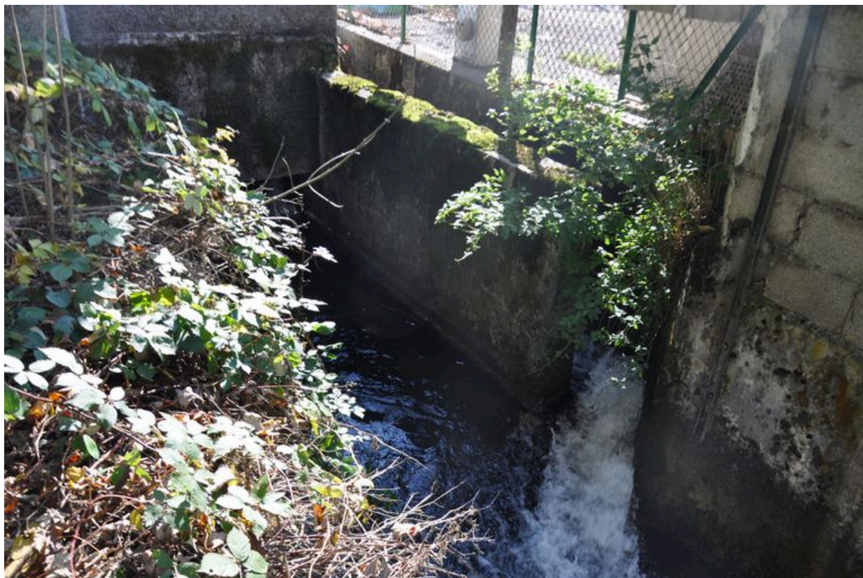
Canal d'alimentation provenant du ruisseau du Saint Ruph
