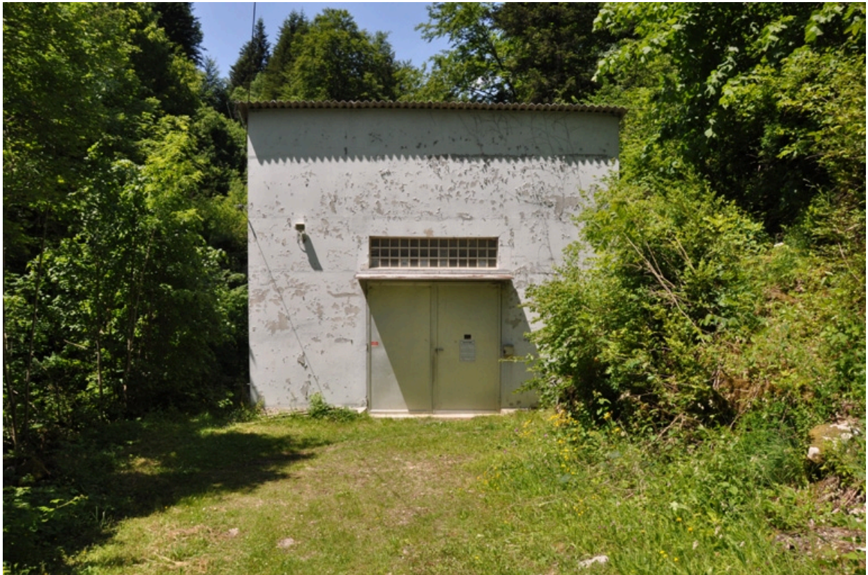
Vue générale de la centrale hydroélectrique, façade est
