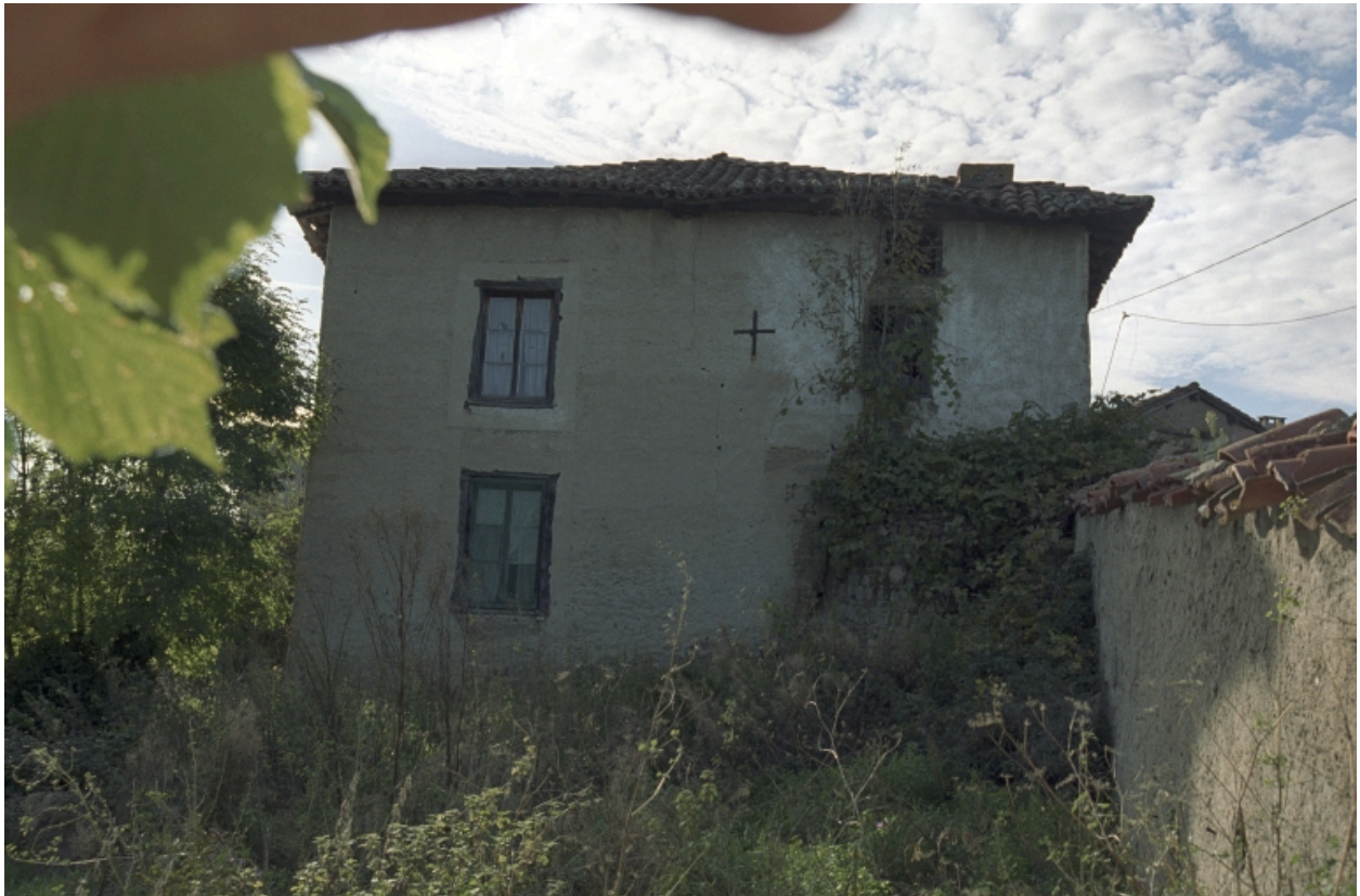
Façade postérieure du logis actuel.
