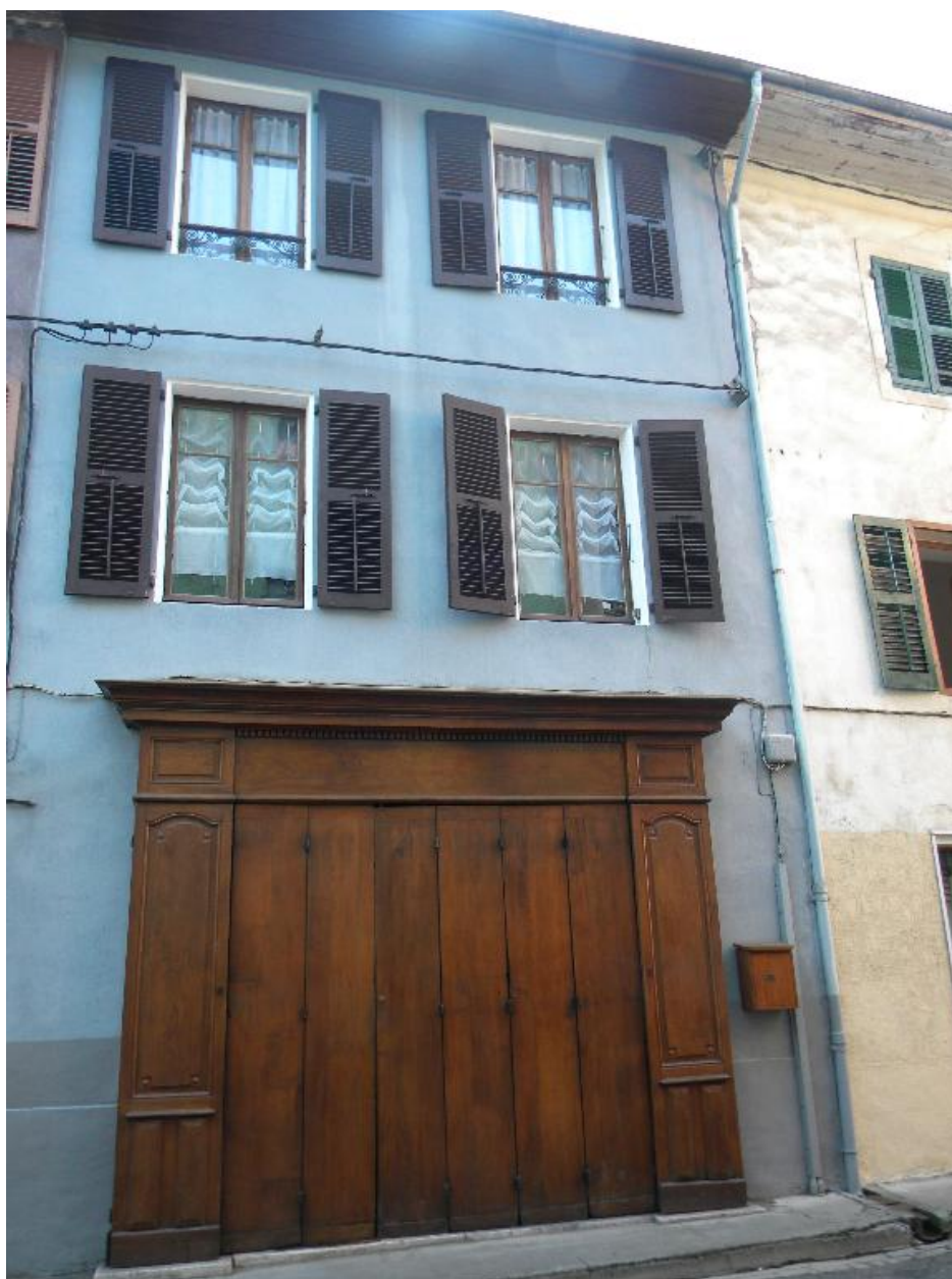
Façade d'immeuble avec devanture commerciale rue Nicolas Blanc (2008 D15 2532).
