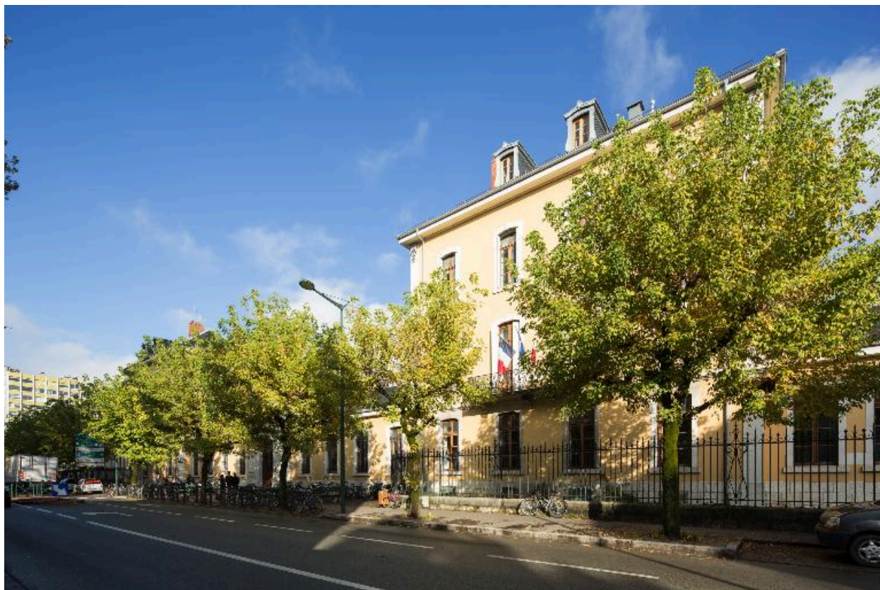
Façade boulevard du Lycée.
