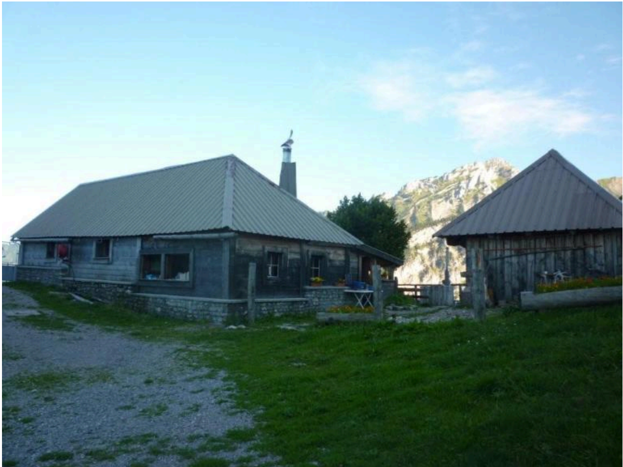
Vue du bâtiment d'habitation transformé en refuge et de l'abri à bois lui faisant face.
