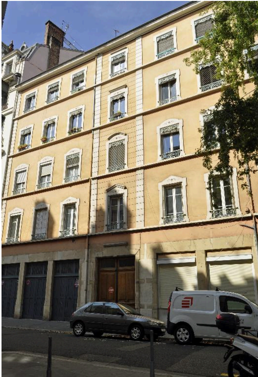
Immeuble sur rue, vue générale de l'élévation sur rue
