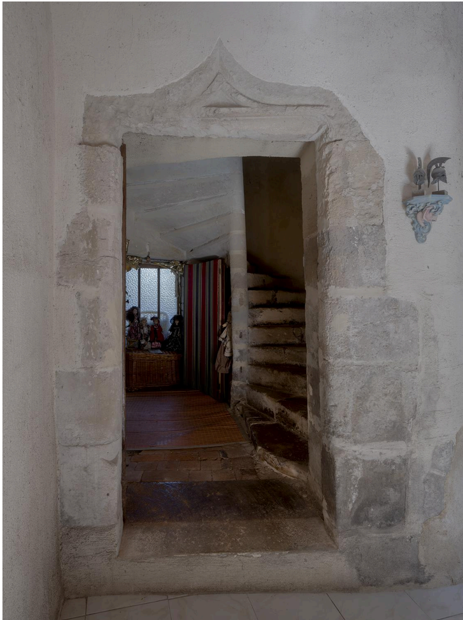
Vue de la porte d'accès à la tour d'escalier
