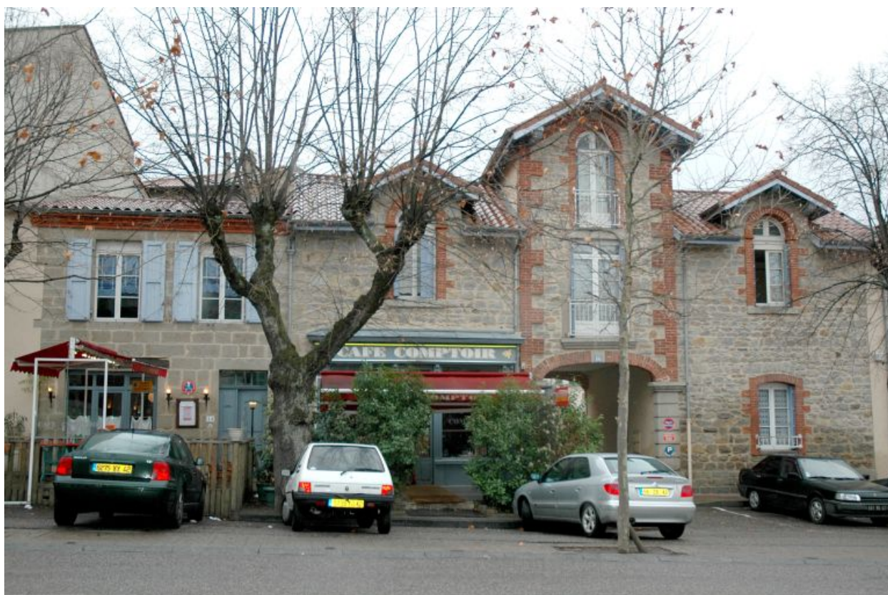
Vue générale de la maison, partie gauche.
