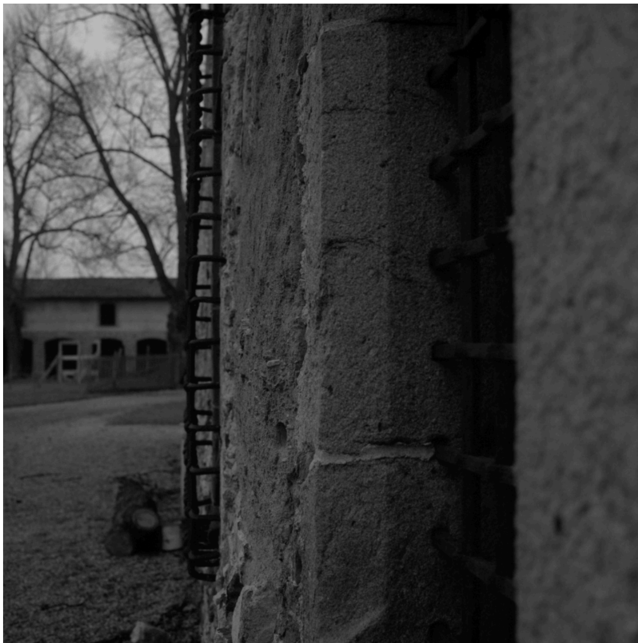
Façade sur jardin du corps de galerie après décroûtage, partie centrale en pisé du corps primitif : détail du fruit formé par le mur à l'endroit d'une baie.
