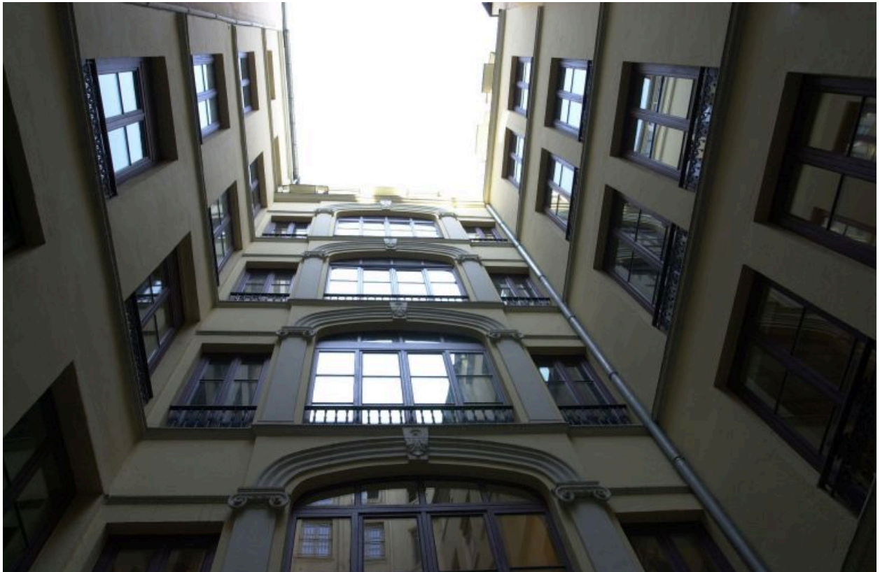
Vue générale des élévations sur cour
