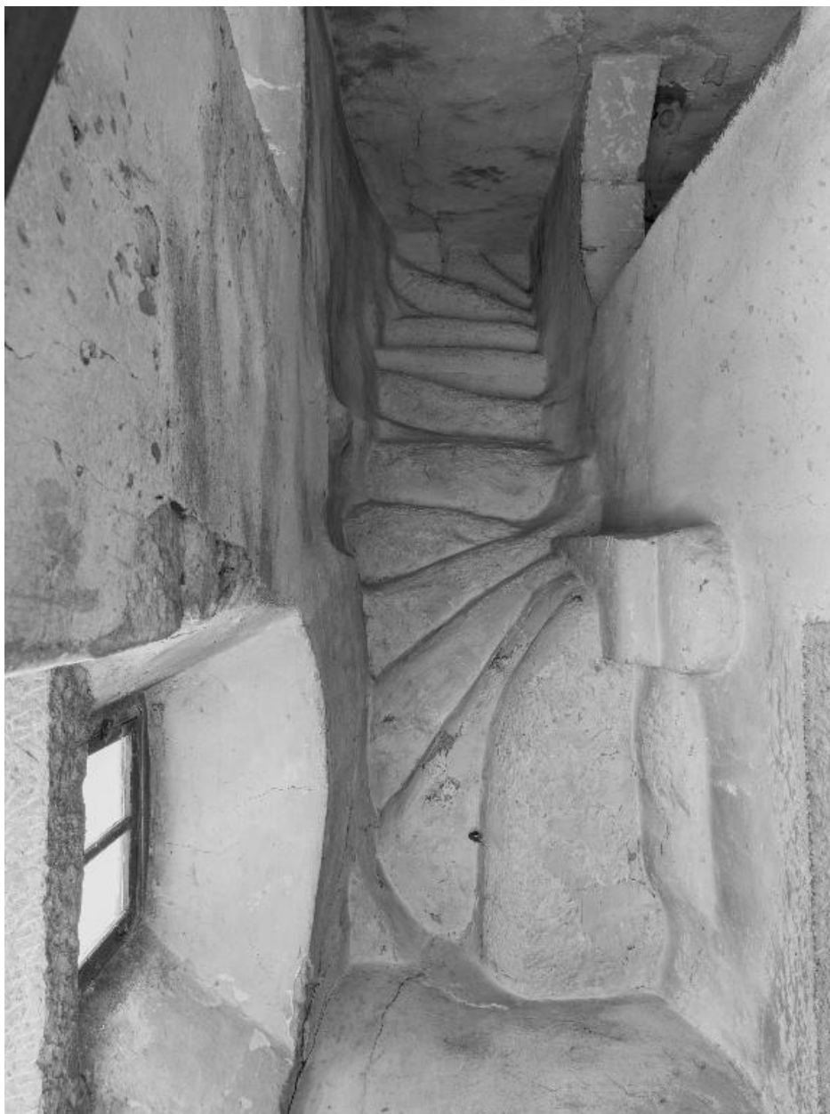
Vue intérieure de l'escalier : vue du dessous de la 2e volée, en contre-plongée.
