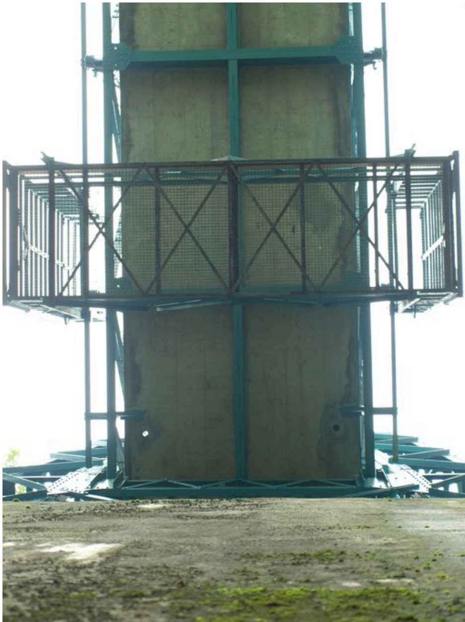
Rive gauche : dessous du tablier et fondation du pylône
