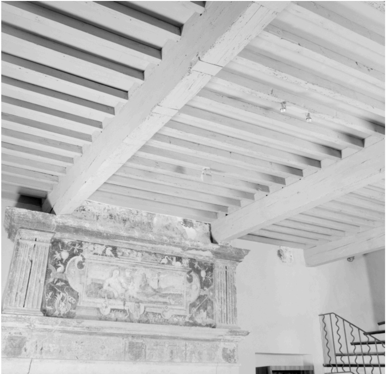
Vue partielle de la salle : plafond à solives et hotte de cheminée.
