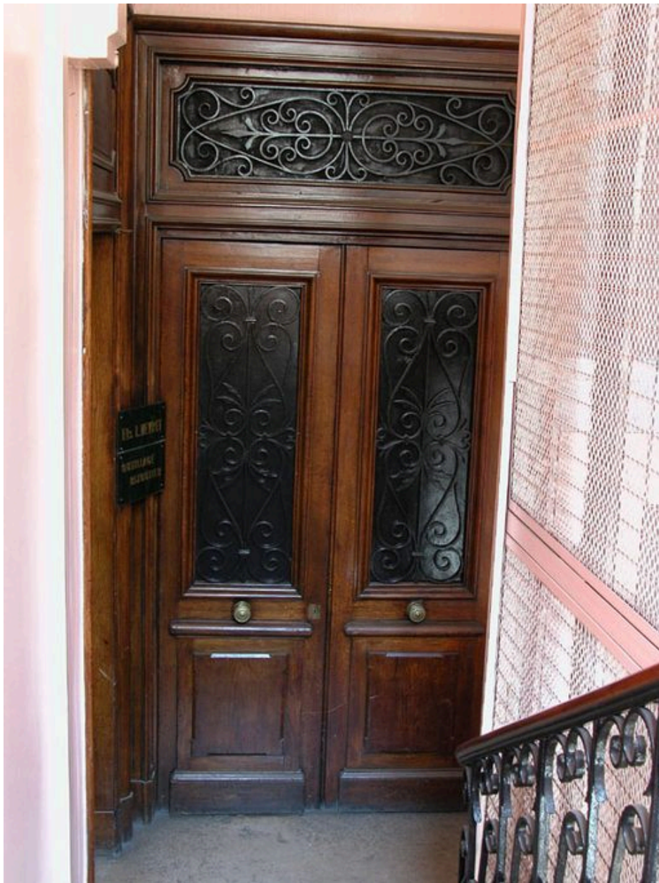
Détail d'une porte palière à deux vantaux et imposte
