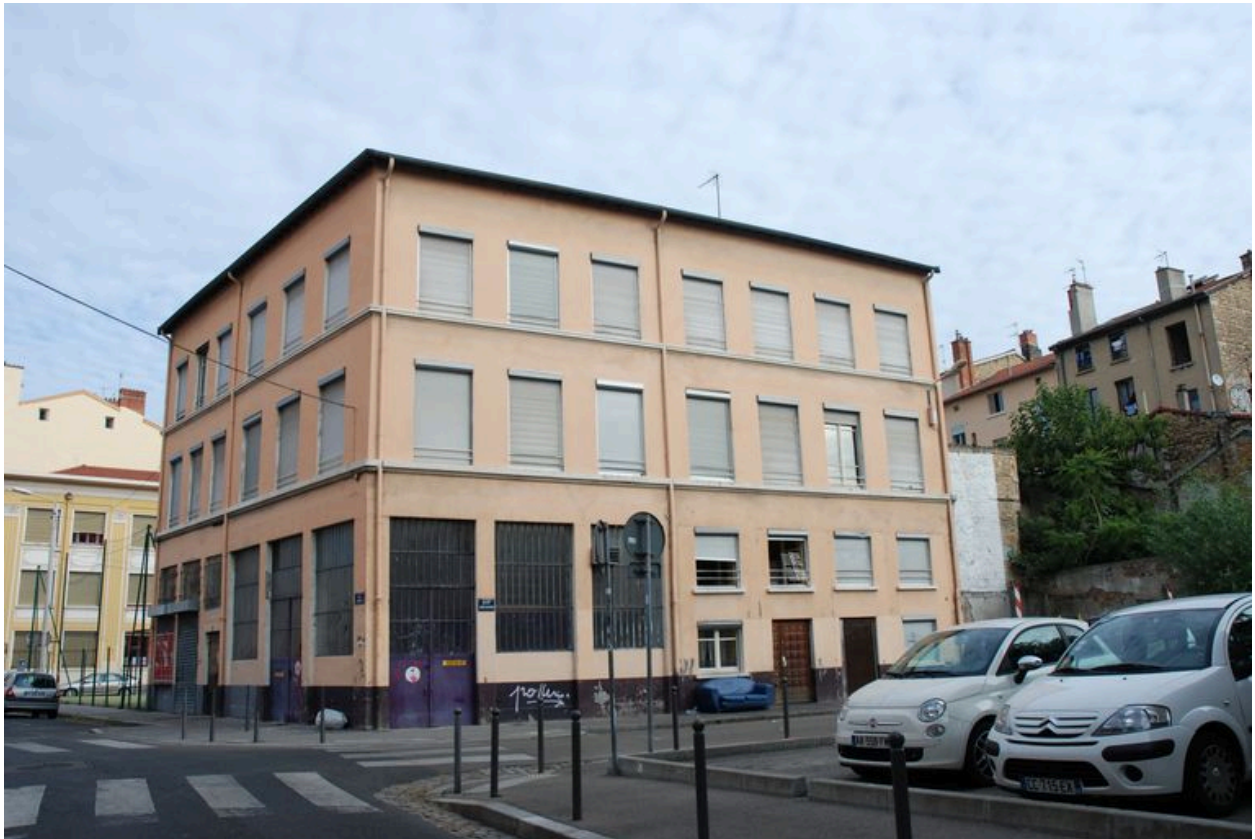
Vue générale (état août 2012).
