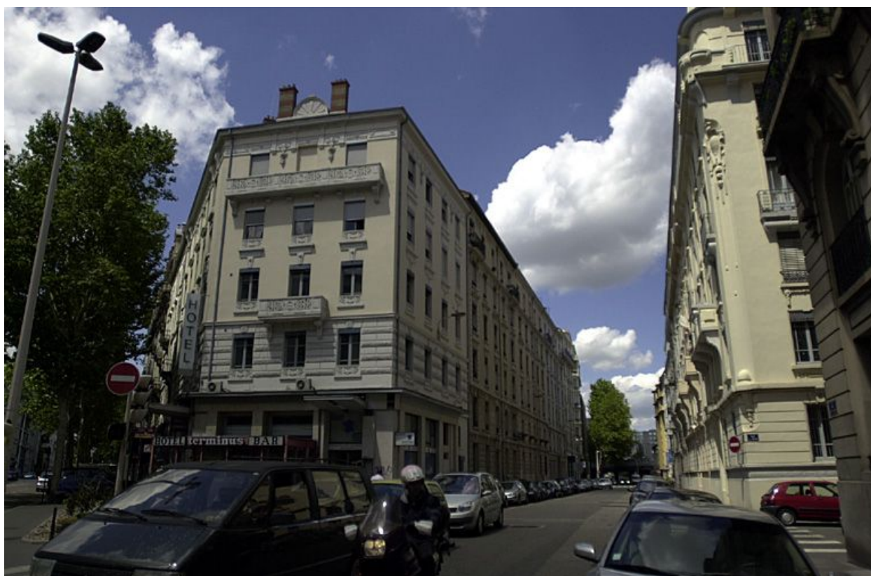
Elévations sud et est depuis la rue Waldeck-Rousseau
