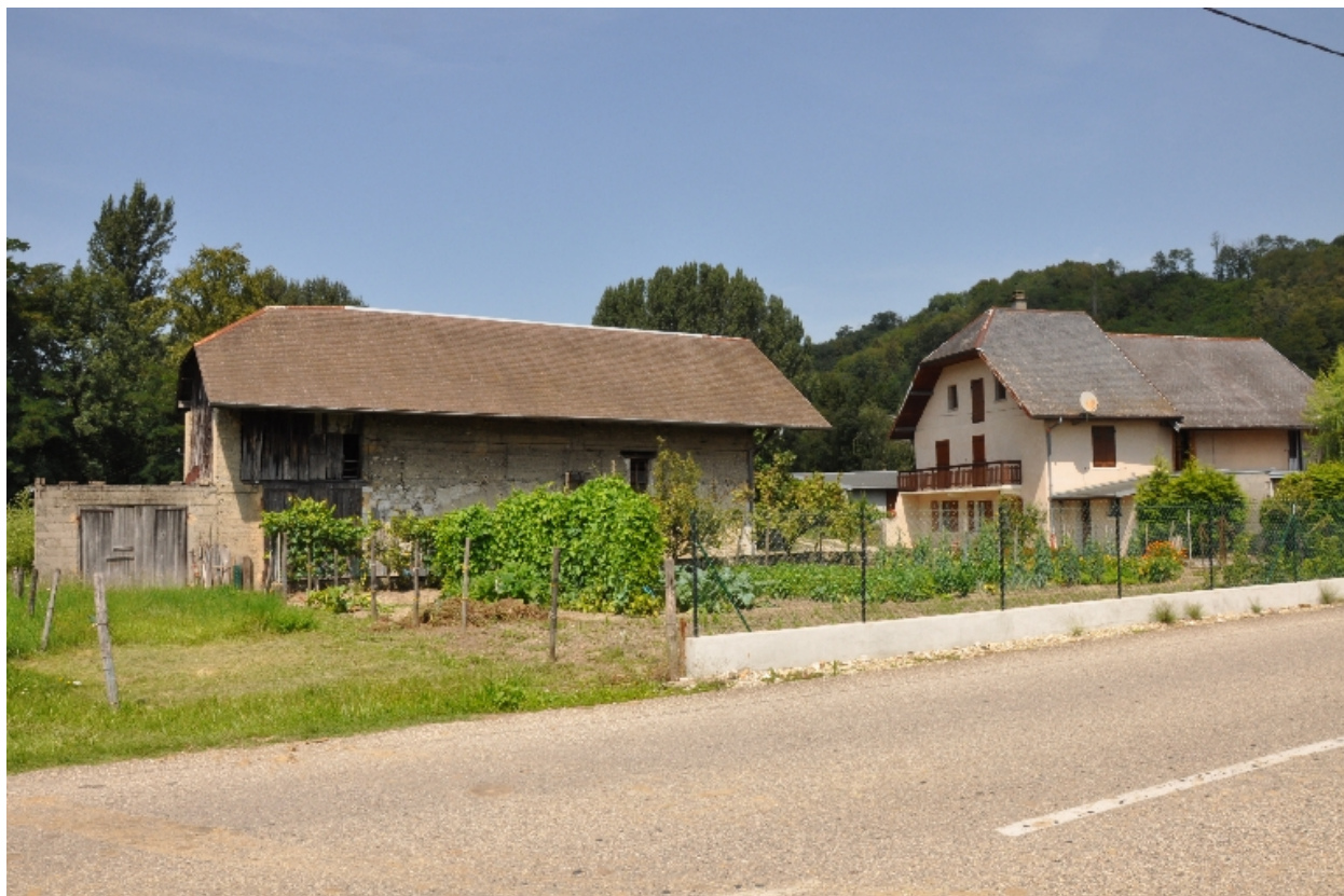
Vue des bâtiments se trouvant à l'emplacement du moulin Chiron
