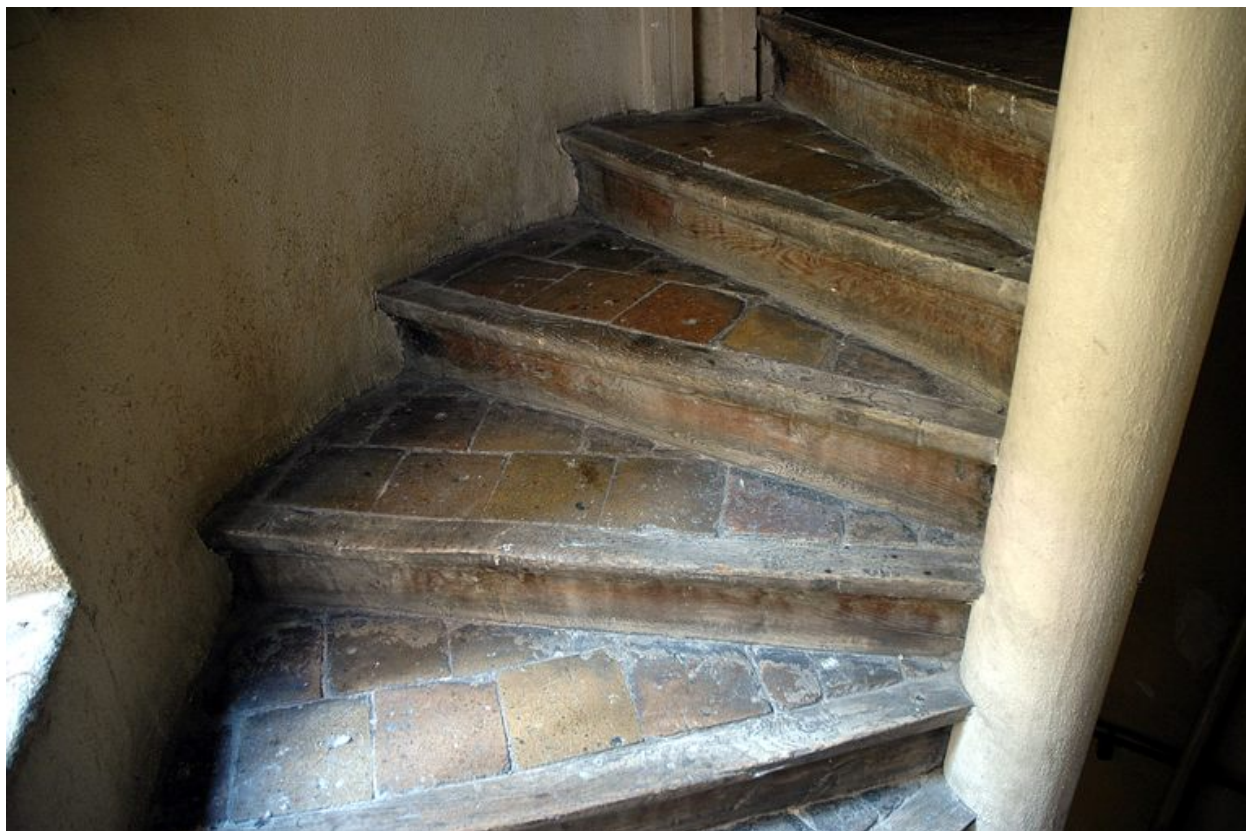
L'escalier : dernière volée et marches en bois et carreaux de terre cuite
