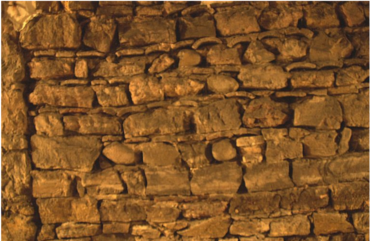
Caves sous l'immeuble 3 rue de Savoie : détail de l'appareillage
