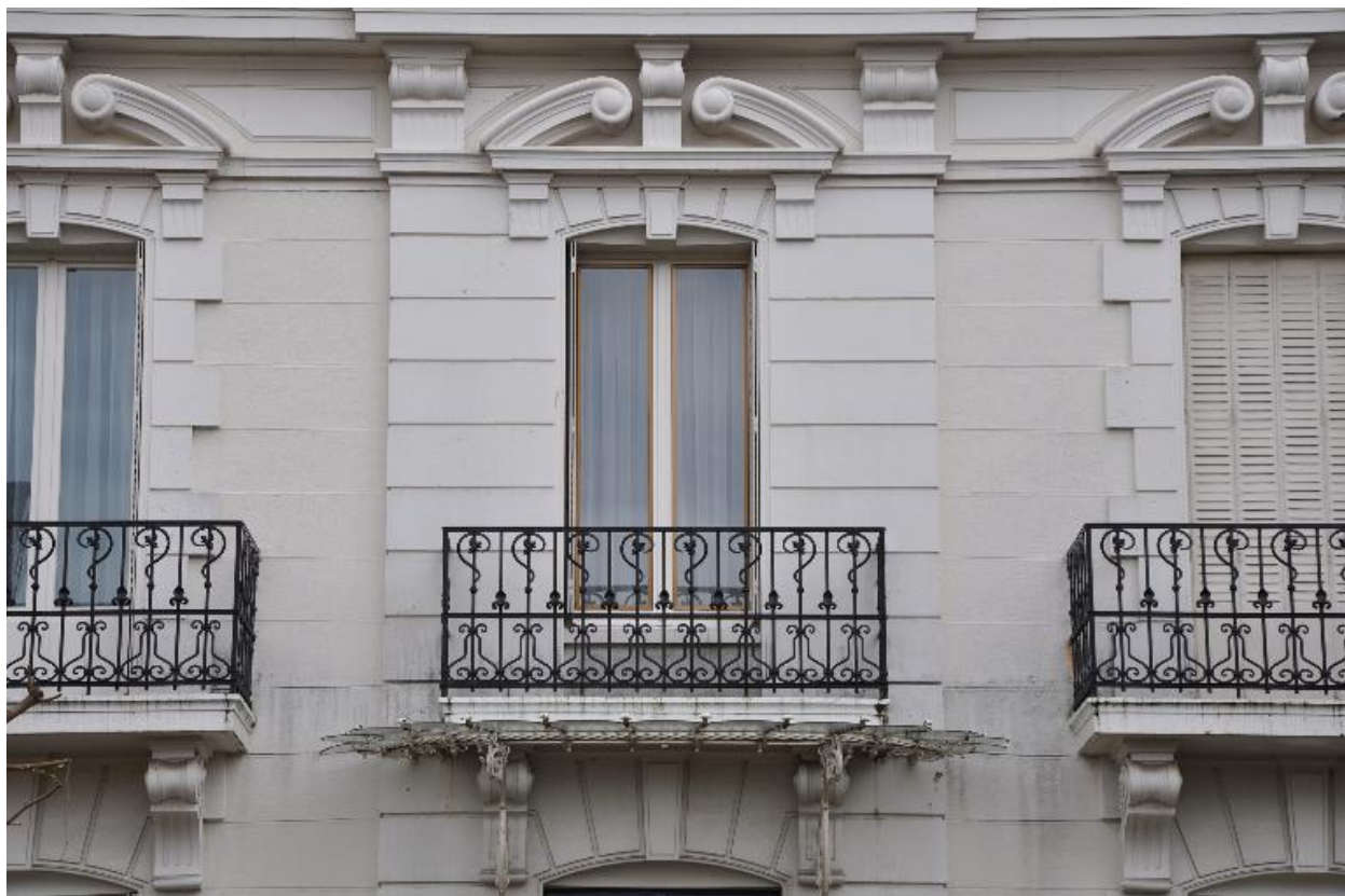
Détail des baies
