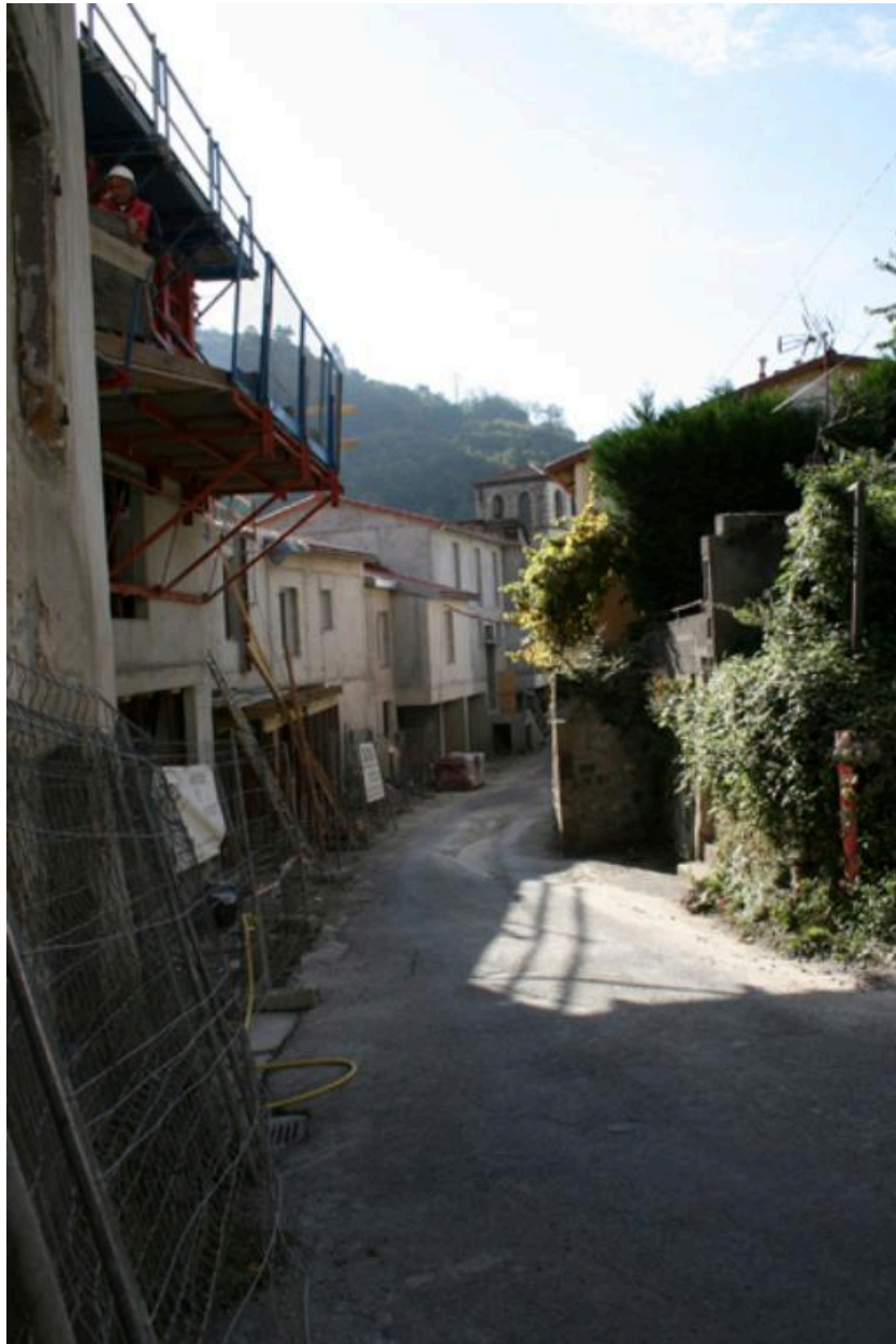
Travaux de réhabilitation de la rue, courant 2011 (photographie chercheur).
