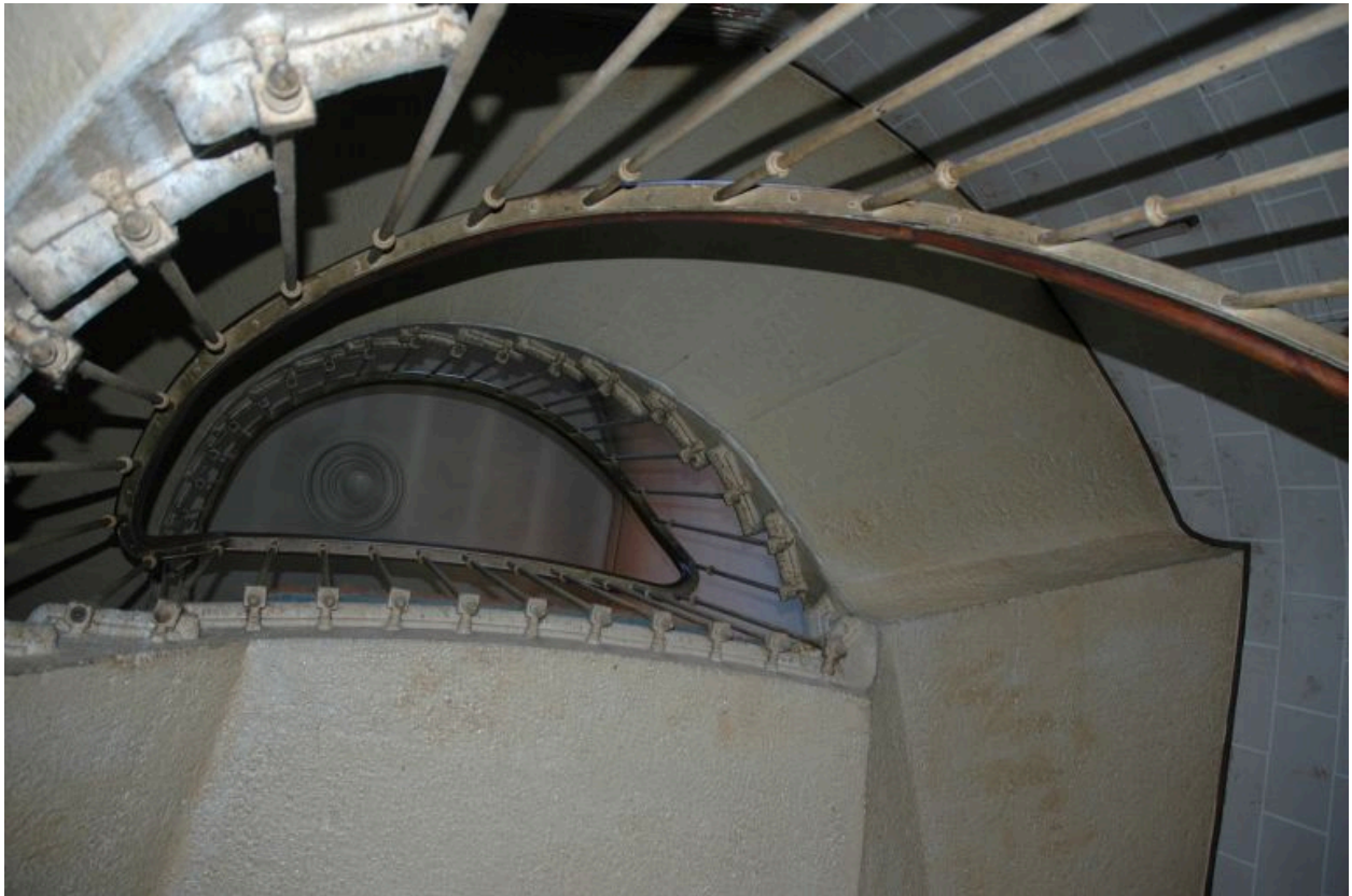
Vue de la cage d'escalier, de bas en haut.
