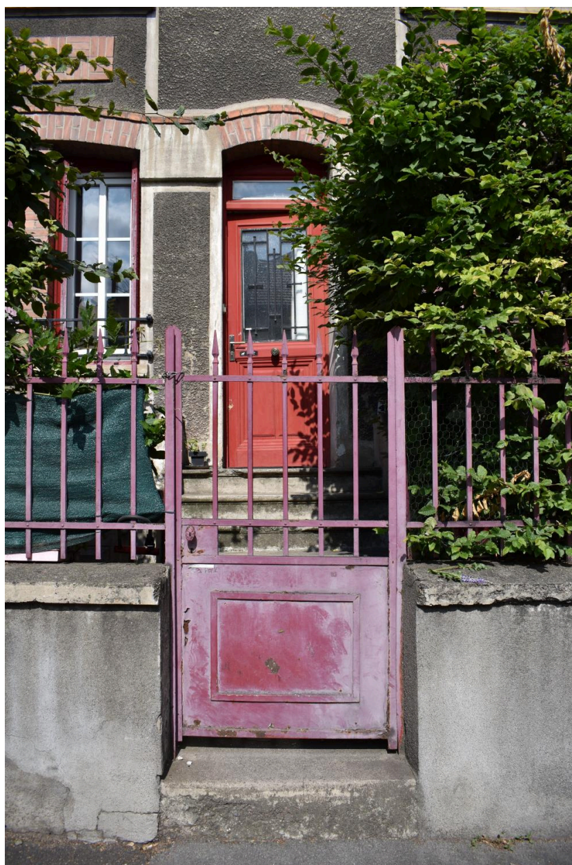
Porte d'entrée desservant le rez-de-chaussée
