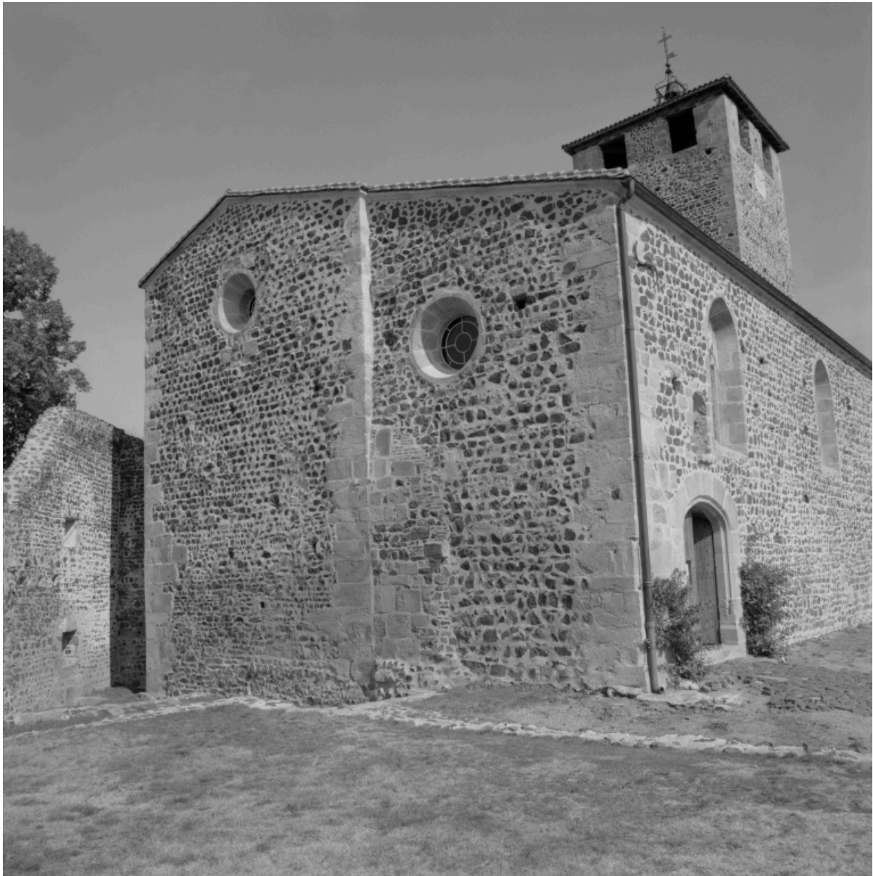
Vue d'ensemble de la face ouest.
