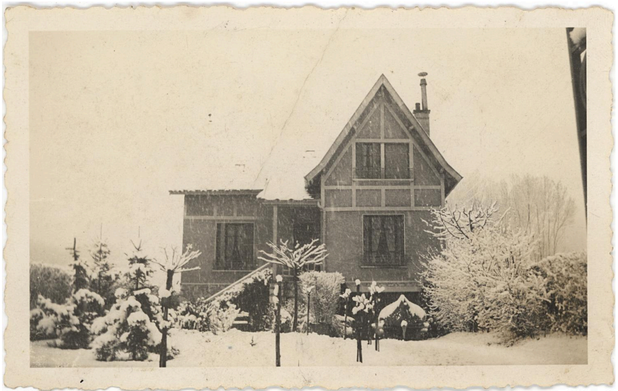
Façade nord. Photogr. milieu XXe siècle
