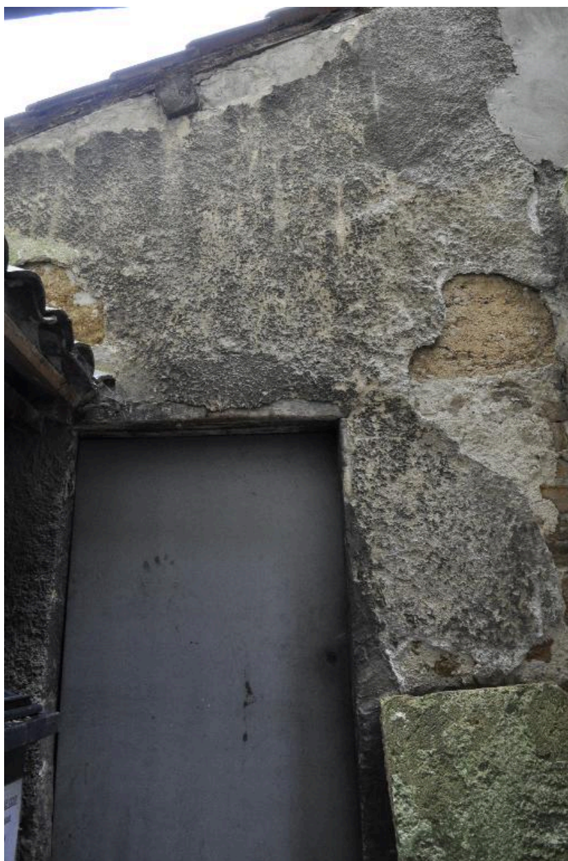
Annexe sur cour en pisé
