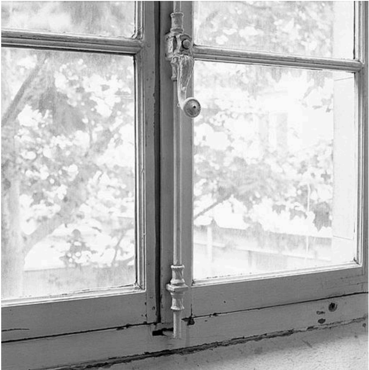
Crémone d'une fenêtre du couloir du premier étage de l'ancienne école de filles
