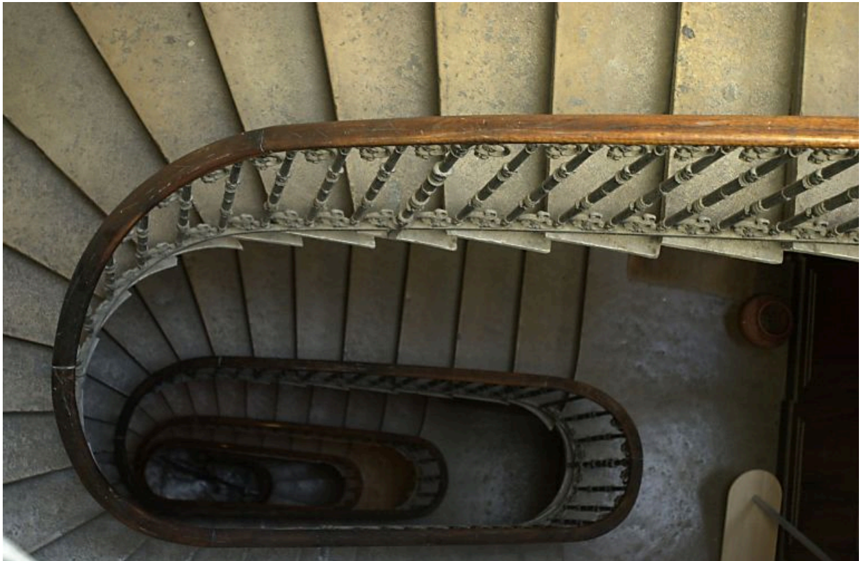
Vue générale de l'escalier depuis le haut
