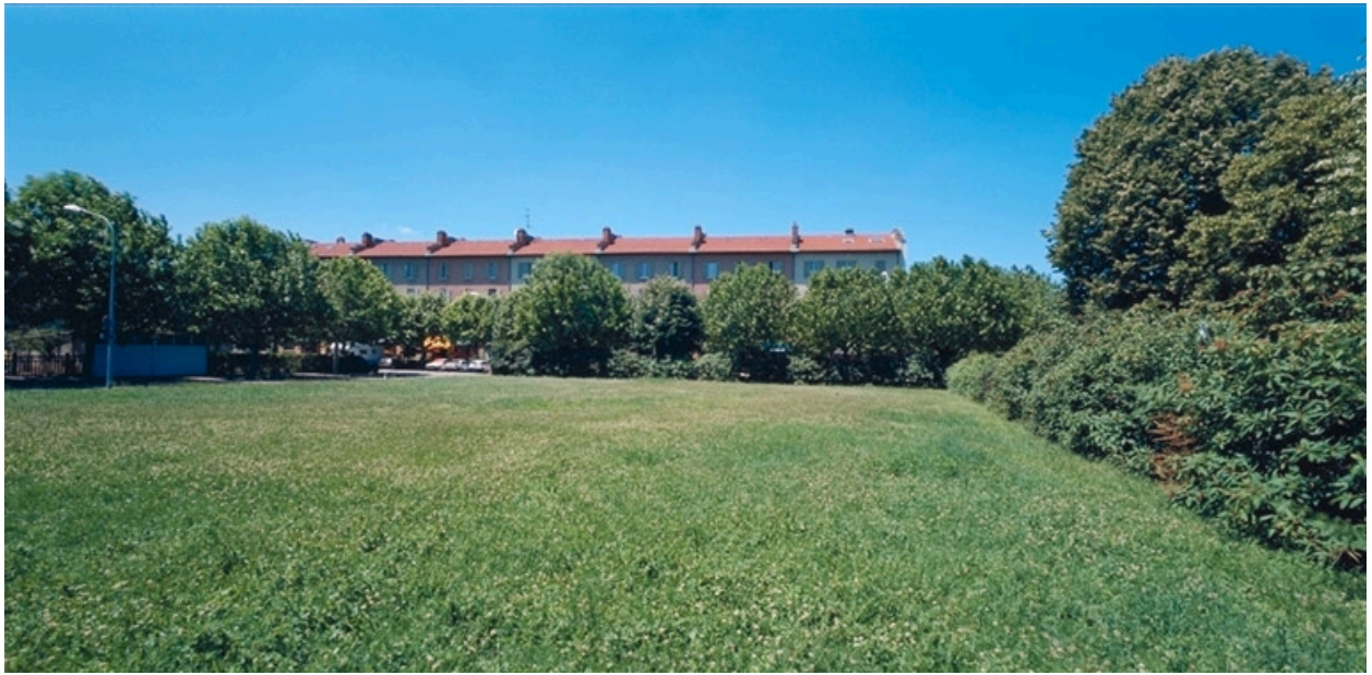
Vue sud de la grande maison
