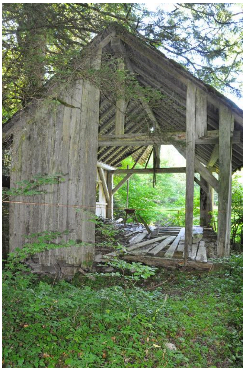
Vue du pignon ouest de la scierie.
