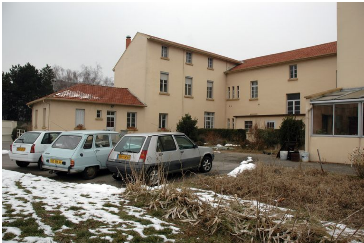
Elévation postérieure depuis le sud-est
