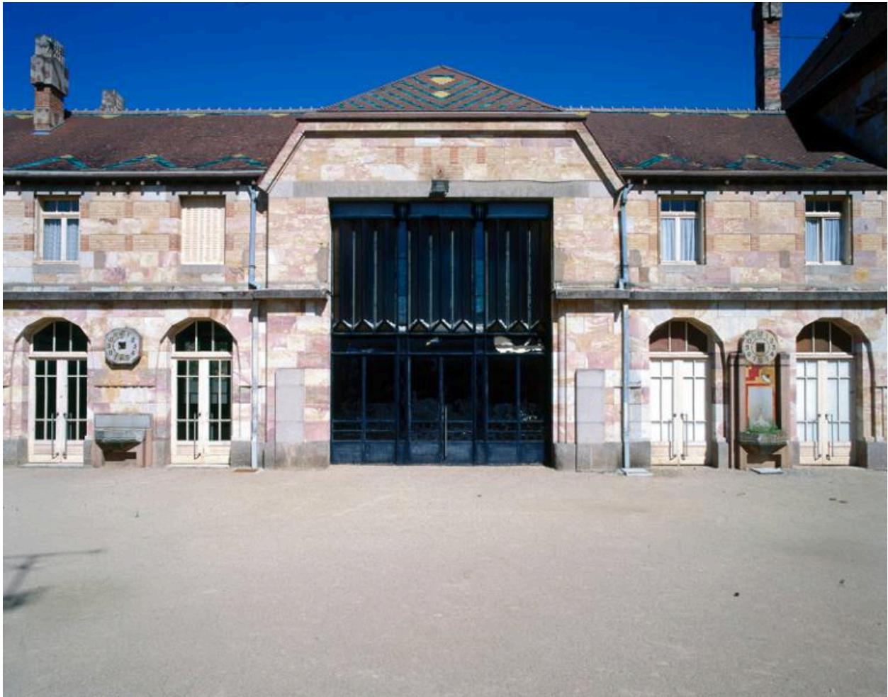
Détail de l'élévation arrière (ouest) de l'ancienne gare de Nérès-les-Bains en 1997, avant réaménagement en centre socio-culturel.
