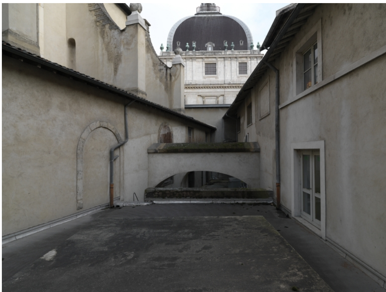
Emplacement de la rue Serpillière entre la chapelle et le bâtiment J, vue vers l'est
