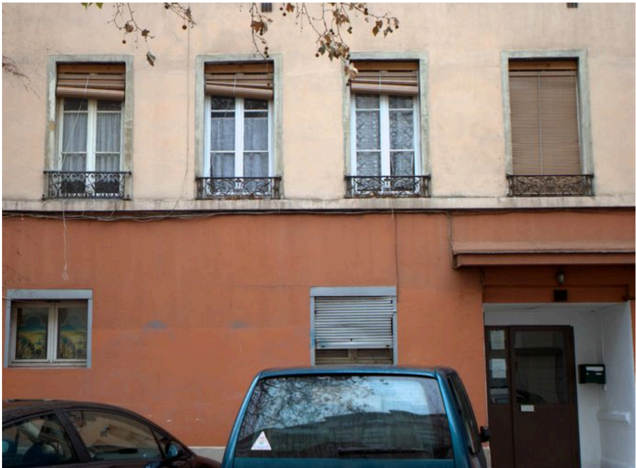
Détail des fenêtres du 1er étage
