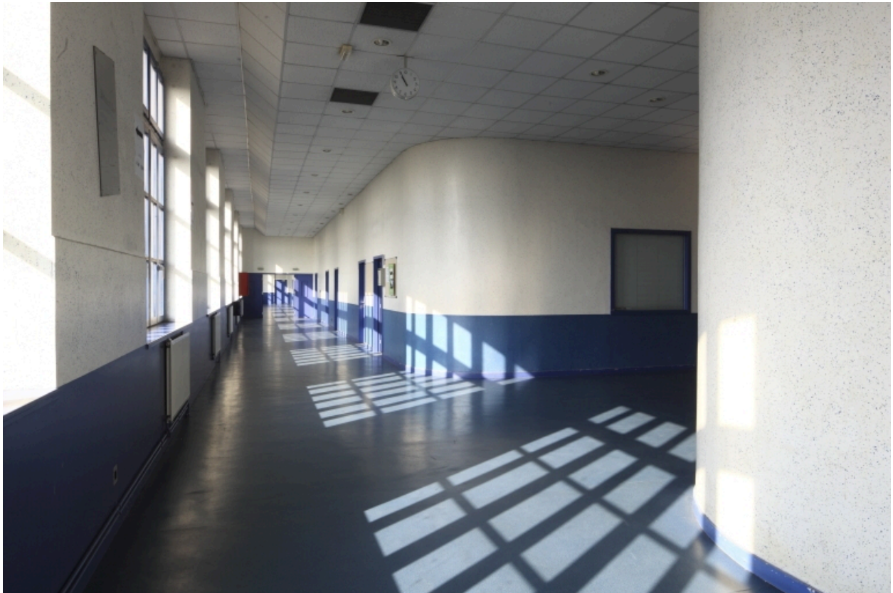
Couloir de desserte des salles de cours, 1er étage. Les fenêtres ouvrent sur la façade cours Général Giraud.
