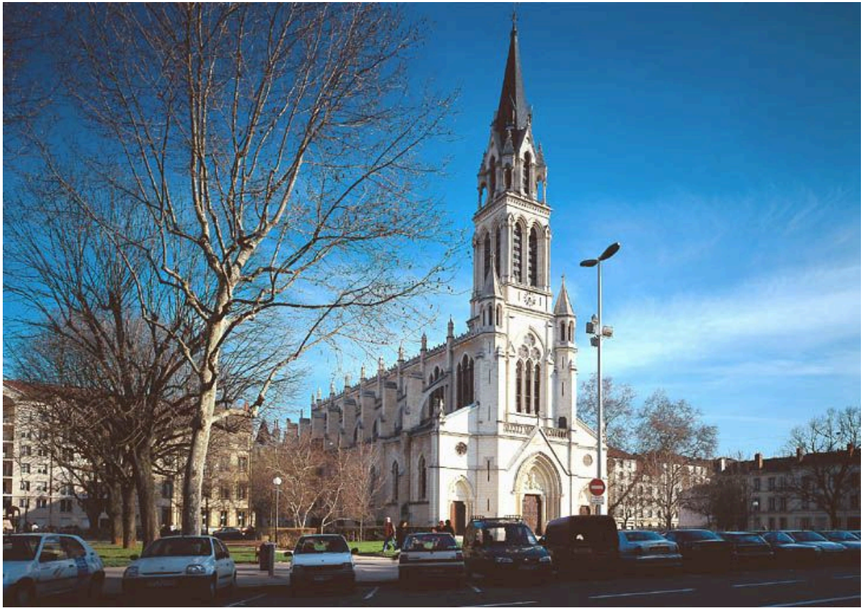
Vue générale : façades ouest et nord
