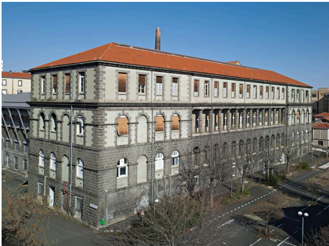
Hôtel-Dieu de Clermont-Ferrand. L'hôtel-Dieu, corps de bâtiment sud vu du sud-ouest.
