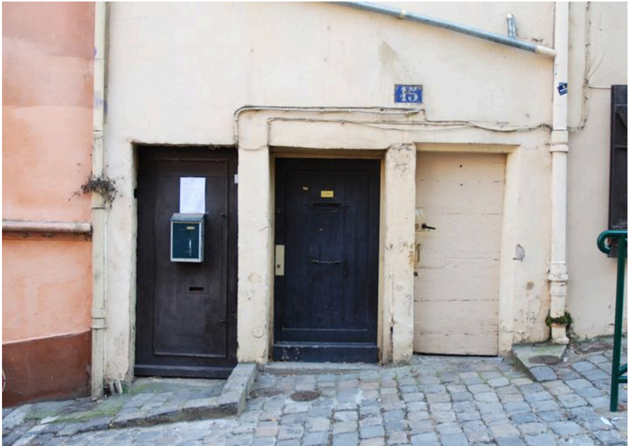
Vue des ouvertures de la partie gauche (porte d'accès aux étages à droite).
