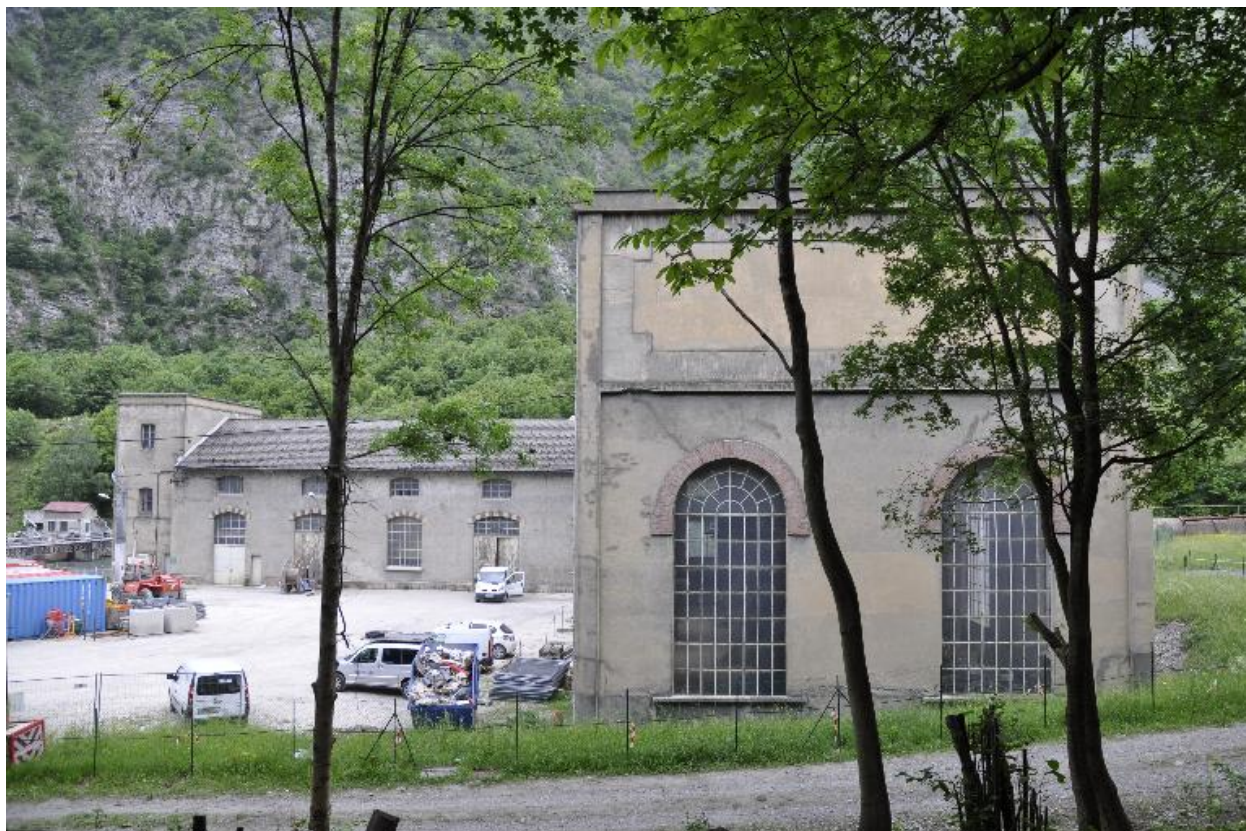
Vue des deux bâtiments composant la centrale
